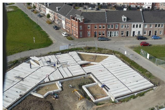
In aanbouw in Helmond: Blok 25 in Brandevoort
